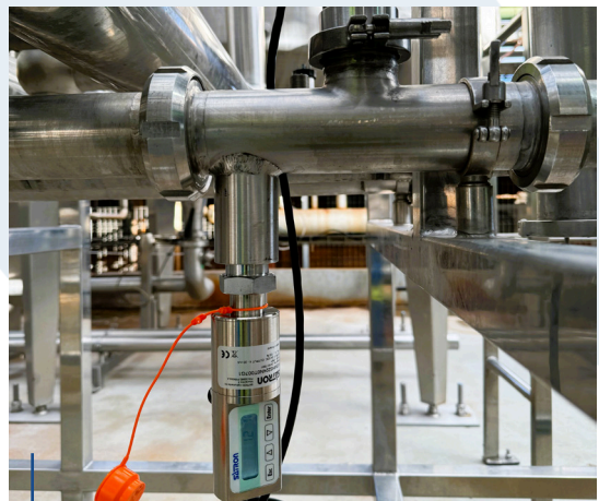
• INDUSTRIA LECHERA, CHILE. Medición de turbidez para control de procesos CIP.
