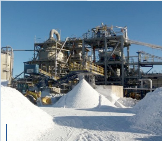
• MINERÍA DE LITIO, CHILE. Medición de flujo másico. Medición de concentración.
